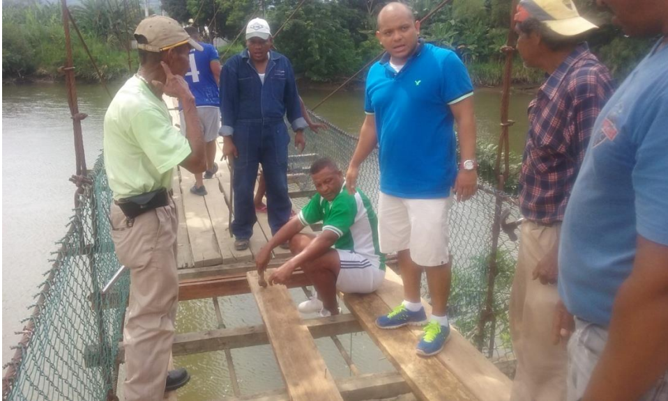
El Ing. Patrick Montaña junto a moradores del sector en la reparación de los puentes.
