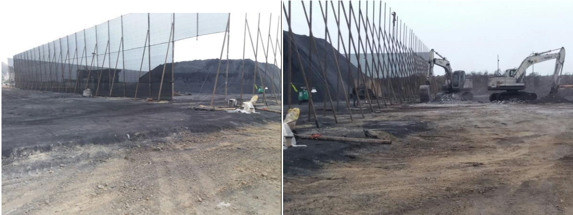
Durante el proceso de confinación del carbón calcinado de petróleo
