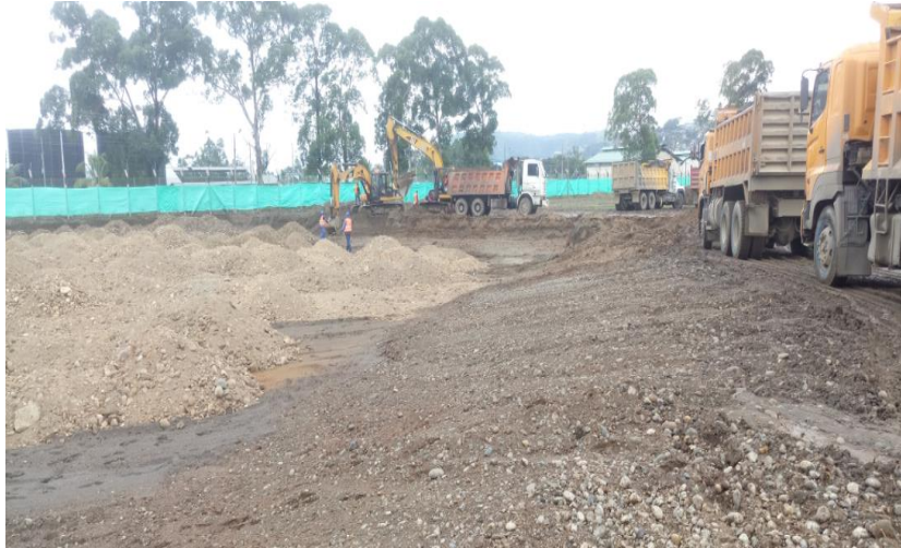
Proceso de cambio de suelo para los patios de almacenamiento.
