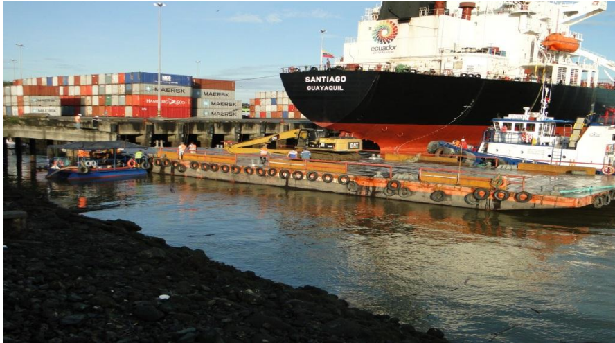
Arribo de la draga a los muelles del Puerto de Esmeraldas
